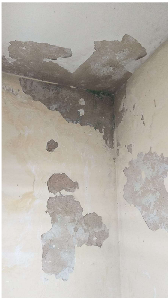
Figura 7- Espaço com marcas de infiltração
